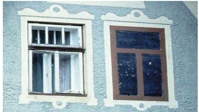
Altfenster brauchen Wartung und Sanierung.
